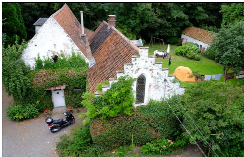
De afhankelijkheden bestaande uit drie gebouwen.
